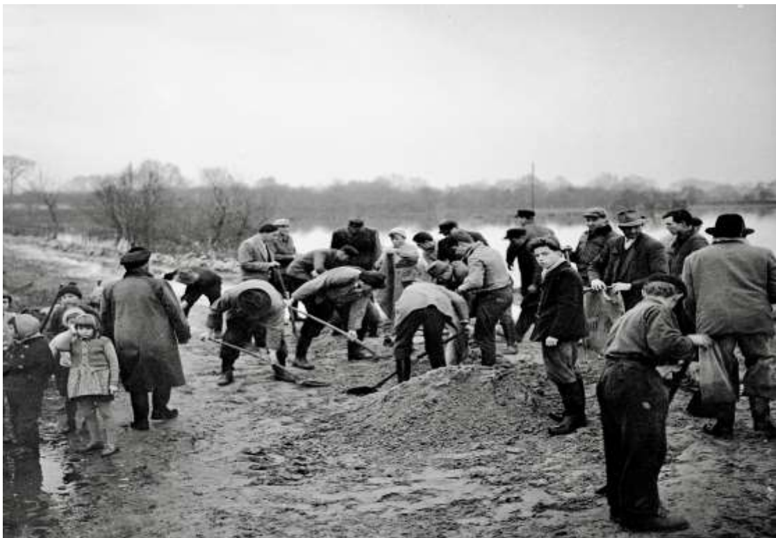
Arbeiten 1961 am Vechtedamm in Neuenhaus (HFN)
