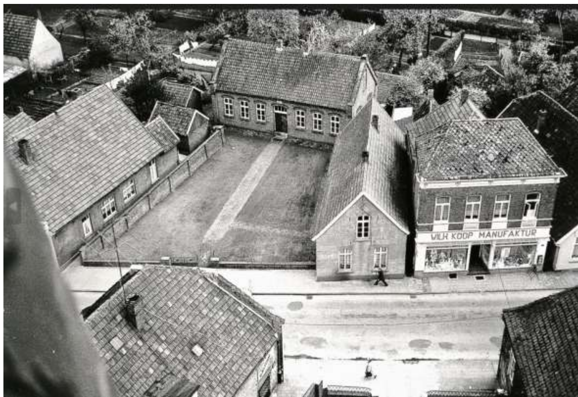
Blick vom Turm der Kirche auf die katholische Volksschule gegenüber von 1878, abgebrochen etwa 1973. Rechts am Platz die vorherige Schule von 1830. Diesseits der Straße links Gaststätte Masselink (später Borutta), rechts das Pfarrhaus, früher genannte Grafenhof, 1973 abgebrochen.
